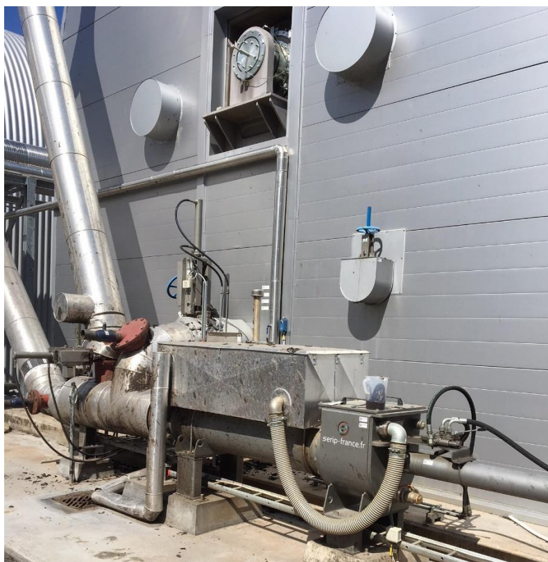
Bild 6 Utmatningsanordning för rötrest från rötchammare, Eon Högbytorp
